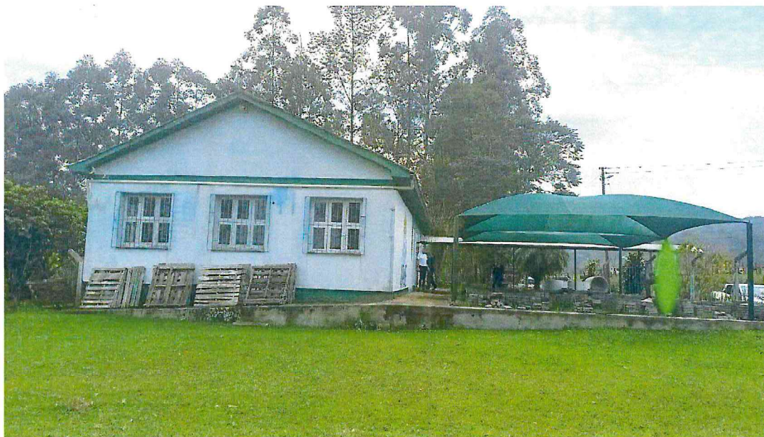
Figura 06 - Lateral da edificação
