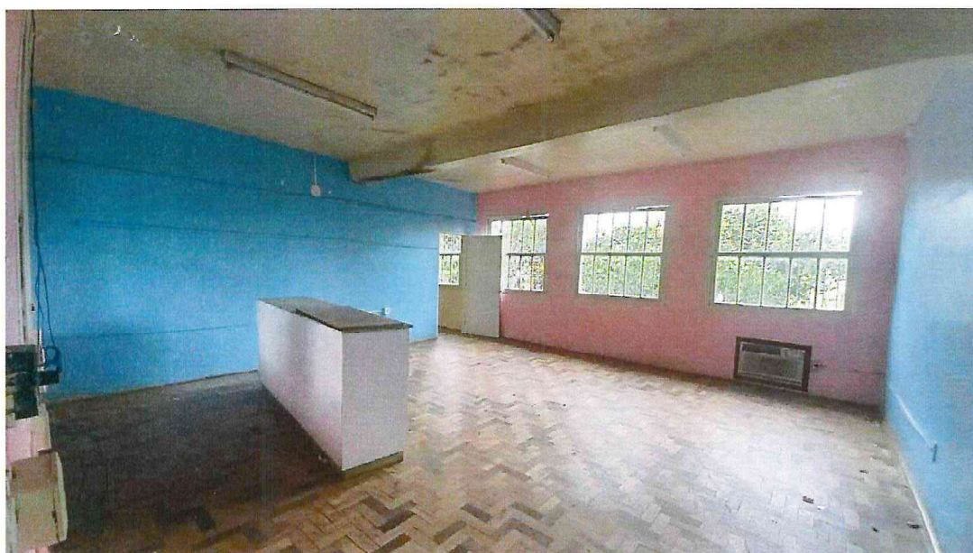
Figura 11 – Fotos internas da edificação.
