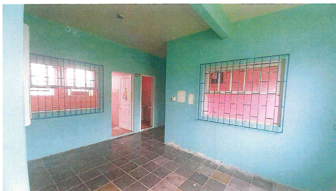
Figura 09 – Fotos internas da edificação.
