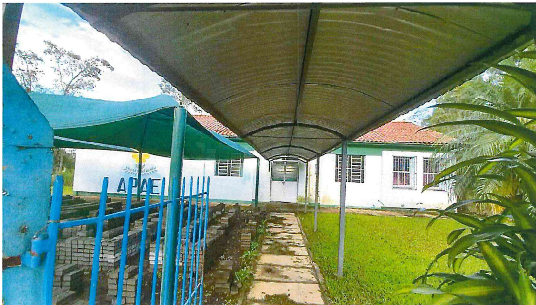
Figura 02 – Imagem da edificação.
