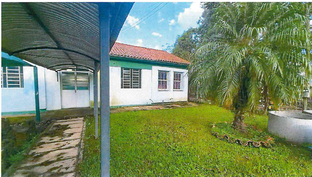
Figura 03 – Imagem da edificação e do pátio.
