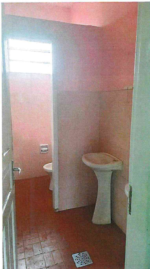
Figura 12 – Fotos internas da edificação – banheiro.
