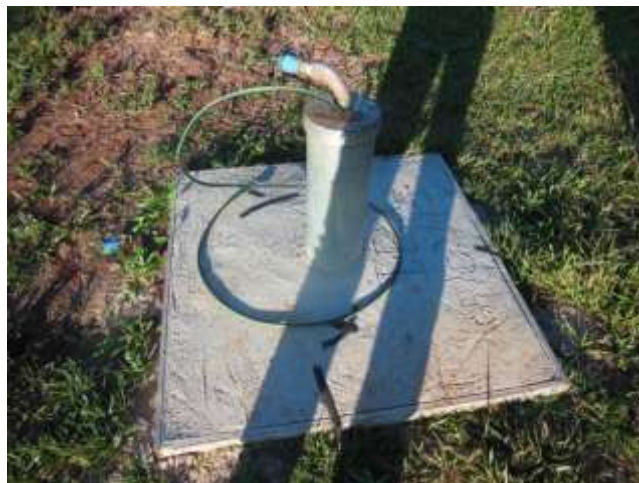
Foto 01 – Laje de proteção de no mínimo 1m 2 .
