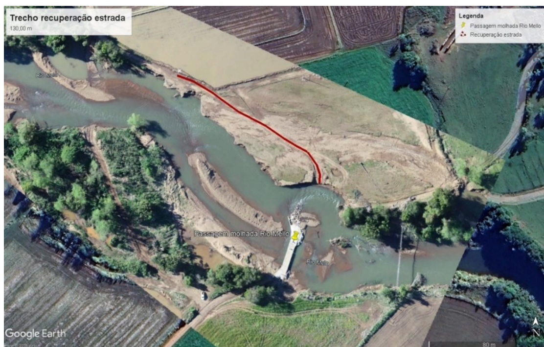
(imagem 02 – trecho de recuperação da via)
