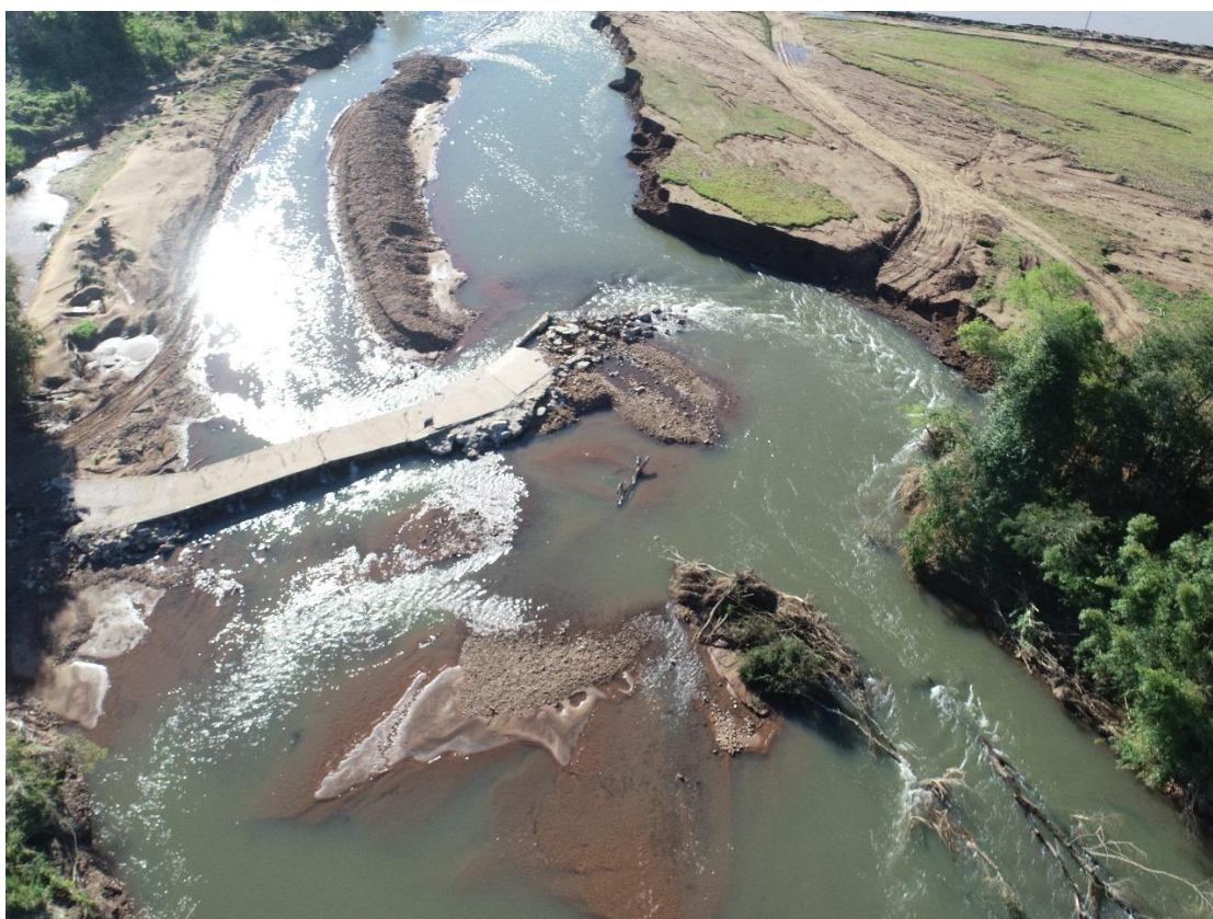
(imagem realizada por drone – local da obra)
