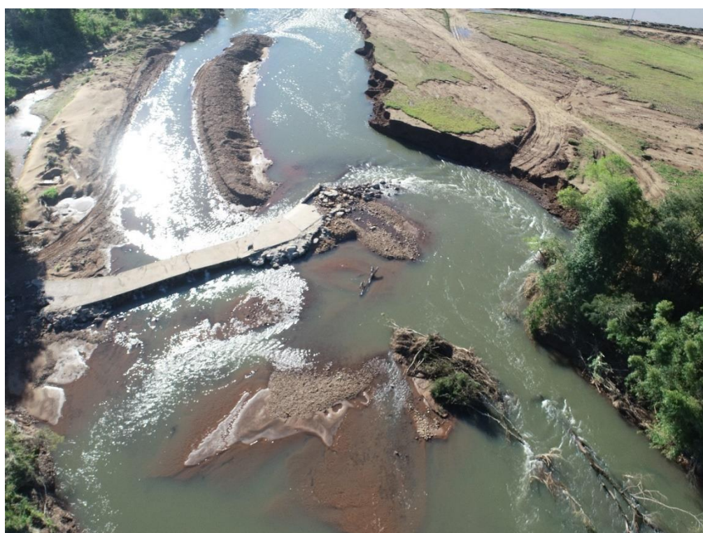
(imagem 03 – imagem realizada por drone)
