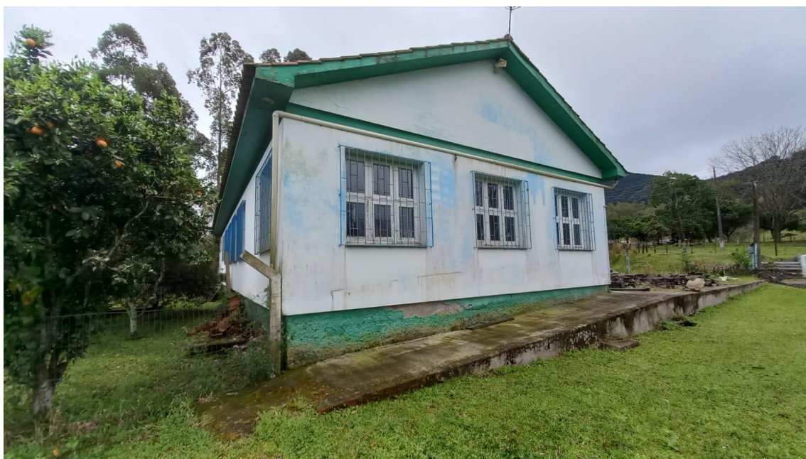
Figura 06 - Lateral da edificação
