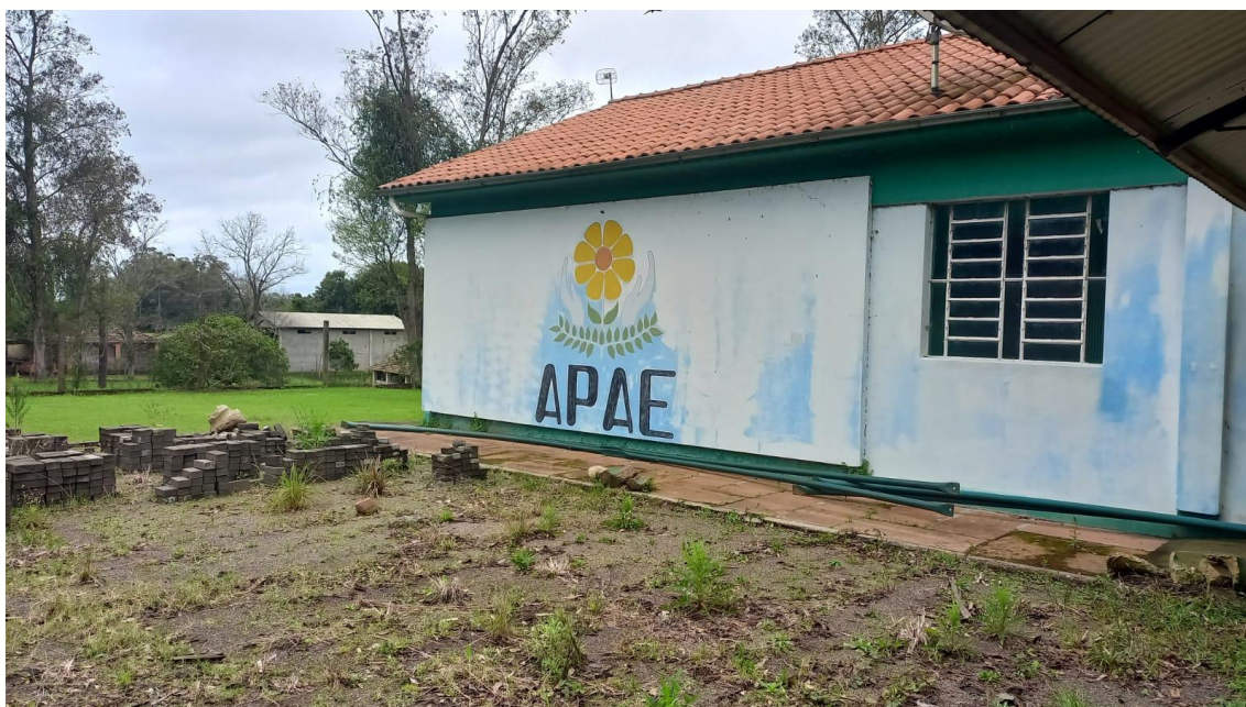
Figura 02 – Imagem da edificação.
