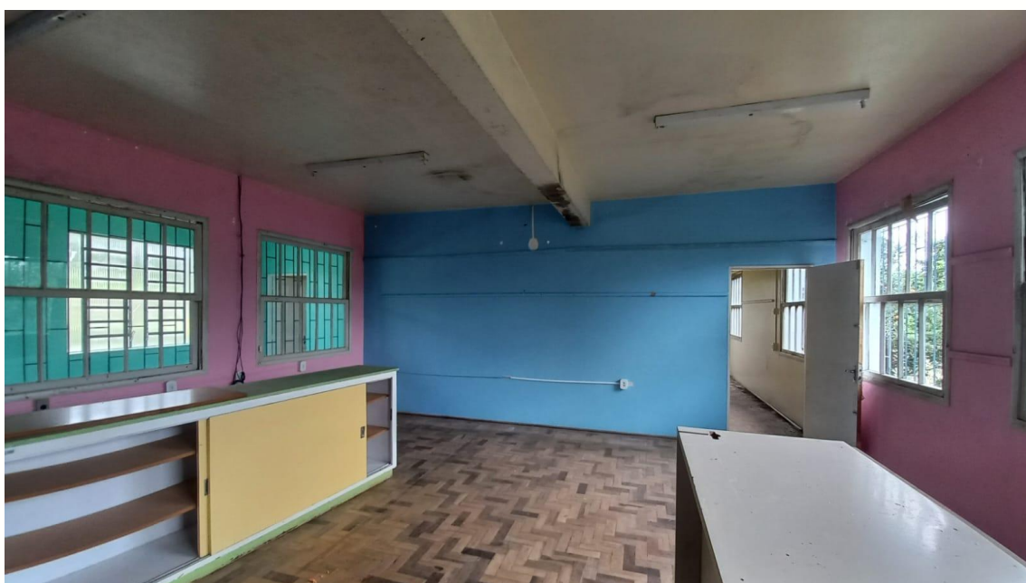
Figura 08 – Fotos internas da edificação.
