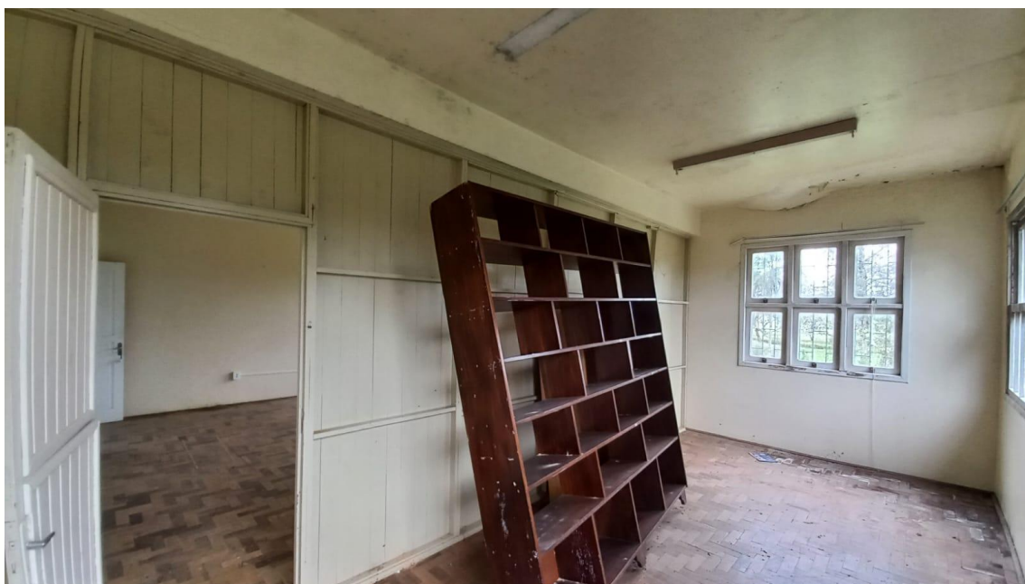
Figura 10 – Fotos internas da edificação.
