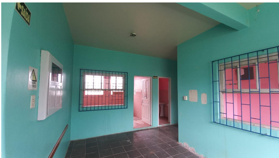
Figura 12 – Fotos internas da edificação
