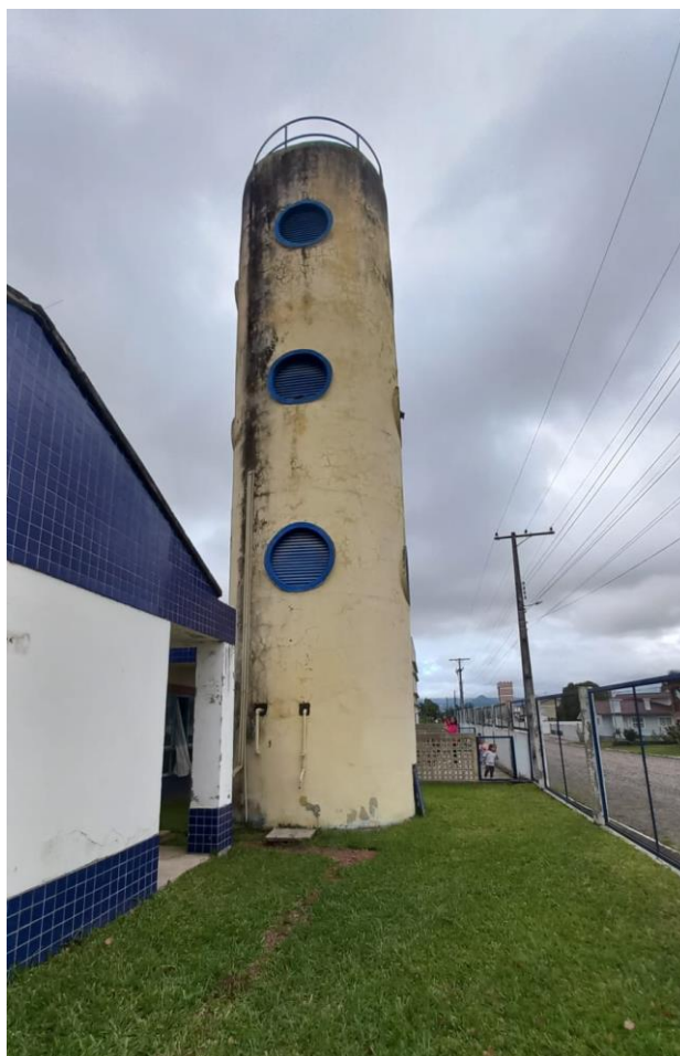
(torre caixa d'água existente)
