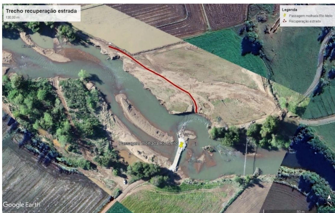
(imagem 02 – trecho de recuperação da via)
