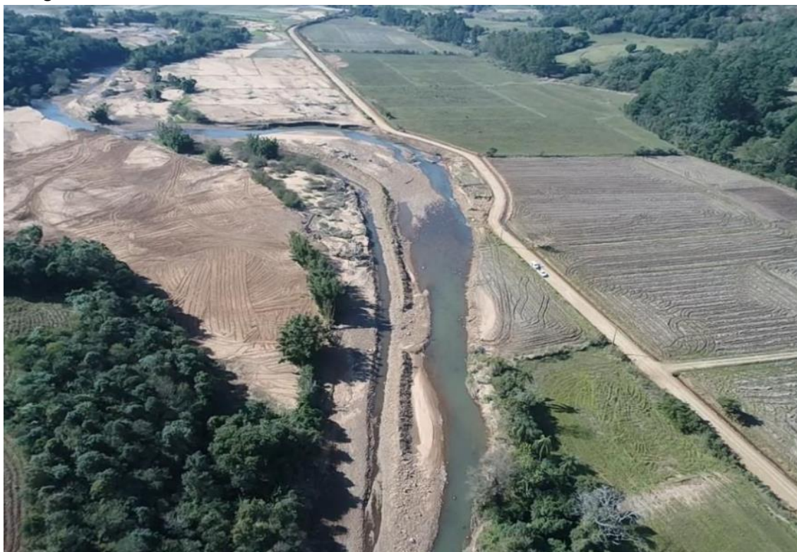
Imagem do ponto 2 após a enchente de 2024, com desvio da estrada (Fonte: UFSM)
