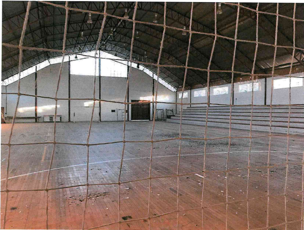
Fig.04- Tablado de madeira existente.
